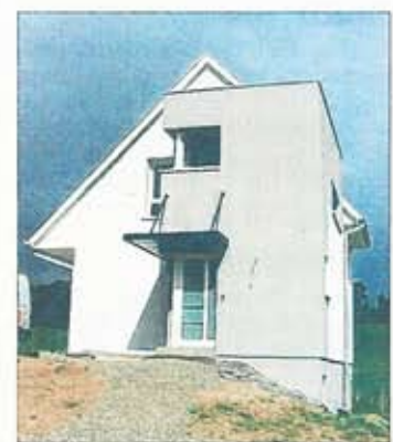
Un sas à l'entrée pour un volume tampon qui évitera de faire rentrer le froid.
